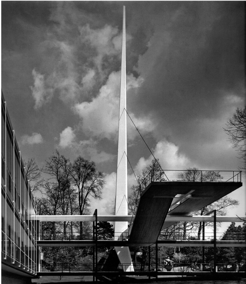
Acceso superior. Upper access.
